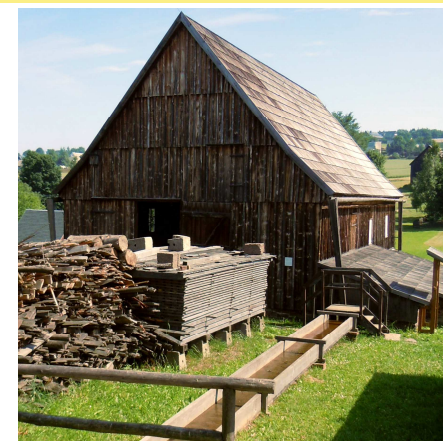
Pila poháněná vodní silou s dřevěnými koryty na přívod vody
